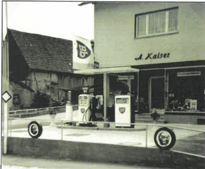
Am 8. Dezember 1966 ging die neue Tankstelle in der Oberen Marktstraße in Betrieb
