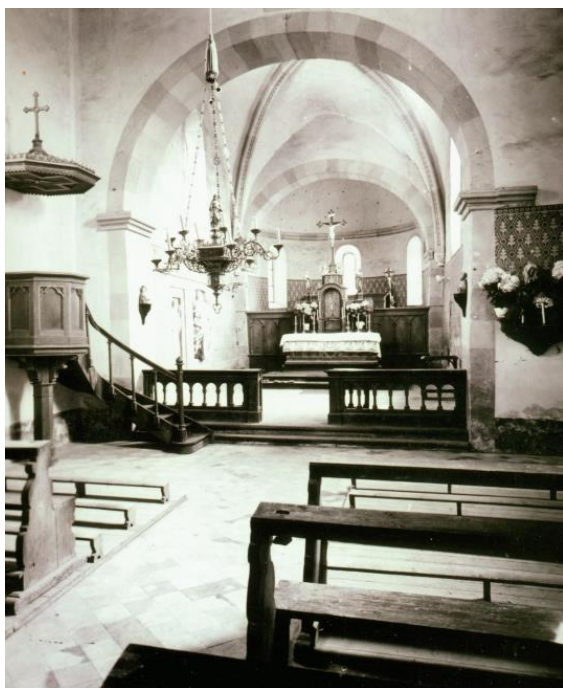
Alle Gegenstände von 1887 wie der Hauptaltar mit Figuren, die Kanzel, die Kommunionbank sowie der Kronleuchter wurden 1972 wieder aus der Kirche entfernt. Im Chorbogen kann man noch die beiden Holzbüsten erkennen.
