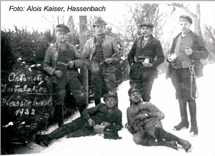
Eine Arbeiterkolonne der Firma Gebr. Löser im Jahre 1922 bei der Erstellung der 6 000-Volt Fernleitung ab dem Kraftwerk Hassenbach im Jahre 1922. Man beachte die 6 kV-Isolatoren in den Händen der Monteure sowie das Gipsgeschirr, mit dem die Isolatoren aufgegipst wurden. Hinter den Monteuren ein Holzmast der Fernleitung. Oben links: der Maschinist des Kraftwerks aus Heidelberg. Unten links liegend: der Hassenbacher Alois Kaiser.
